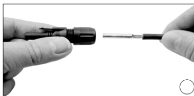
Figura 23 - inserção do terminal confeccionado no isolador MC4
